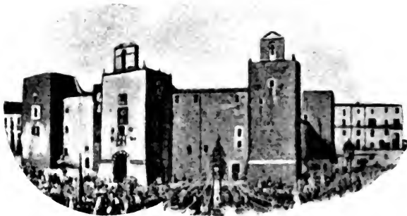
7. - L'ANTICO CASTELLO (ora demolito) e LA PROCESSIONE DEI CANDELIERI A SASSARI.
